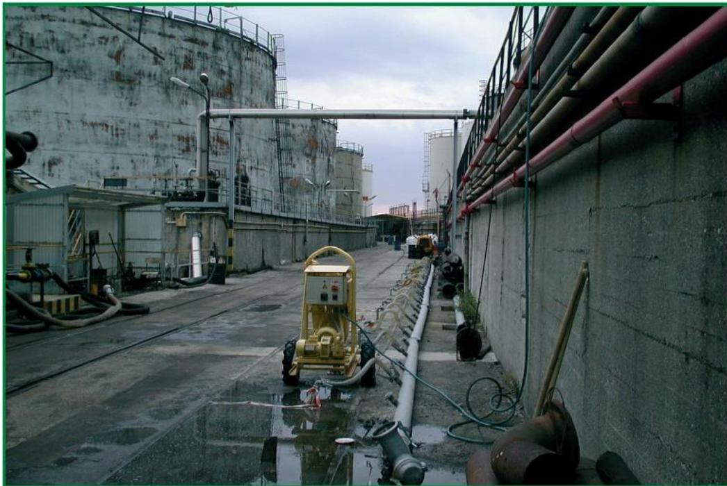
*Batteria di wellpoint per intercettazione acqua di falda contaminata.*
