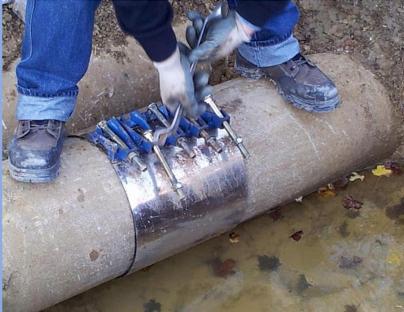
**Questo primo intervento di manutenzione, che non prevede nessuna operazione di taglio, può essere seguito a distanza di tempo dalla sostituzione del tratto di tubazione danneggiato. Una volta accertata la presenza di amianto, si dovrà procedere ad interventi di rimozione delle tubazioni in ottemperanza ai principi generali di prevenzione e precauzione dettati dalla normativa.**
