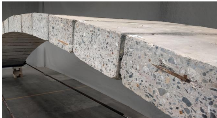
Passerella EPFL in elementi di calcestruzzo recuperato
