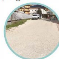
2.3.4 - Piste di cantiere stabilizzate
